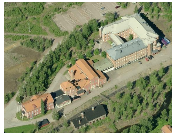
Flygbild över befintliga huvudbyggnader, sett från sydöst. Copyright: Blom/Pictometry
