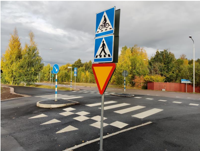
Cykelöverfart längs Källviksvägen
